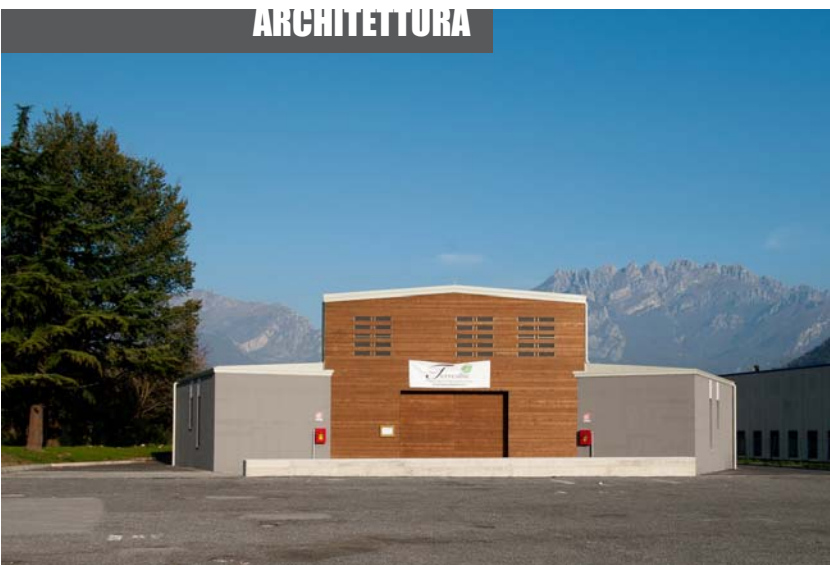
Vista esterna: fronte principale con ingresso da Piazza del Mercato
