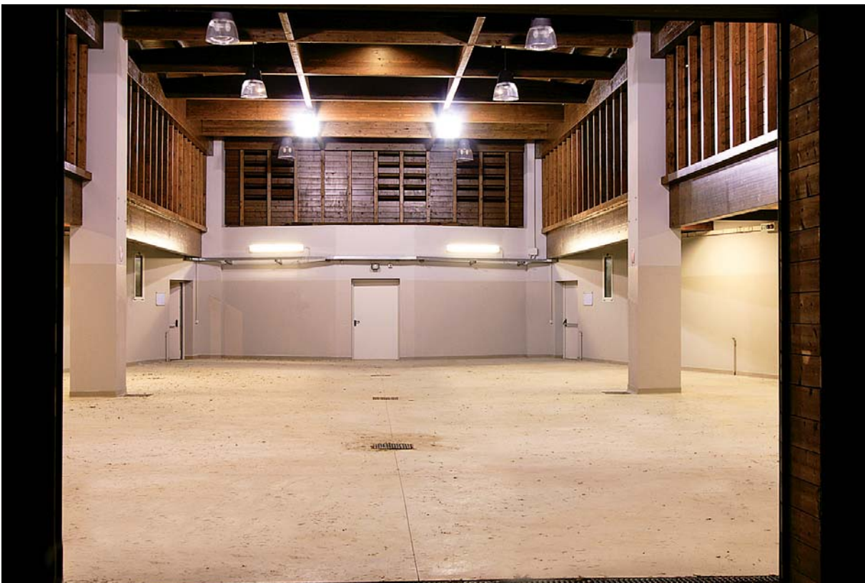
Vista interna con il "sopralzo" in legno
